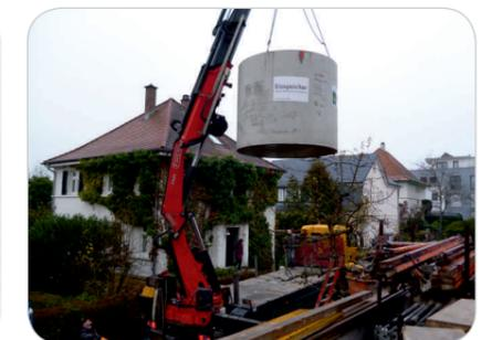
Die Firma Ernspenger hat bei einem seiner Kunden ein Eisspeicherheizsystem realisiert. Mit diesem System steht eine attraktive Wärmequelle zur Verfügung, die sich vor allem für den Neubau eignet. Der Eisspeicher wird als kostengünstige, genehmigungsfreie Alternative zur Erdwärmesonde oder zum Erdkollektor ein-
