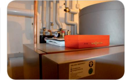
Zu der Heizungsanlage gehört nicht nur primär der Heizkessel; der Pufferspeicher ist genau genommen das Herzstück der Heizanlage. Hier können Heizkessel, Solaranlage und eine Frischwasserstation angeschlossen werden. Ein hydraulischer Abgleich mit Pumpen sorgt für eine effiziente Wärmeverteilung.
